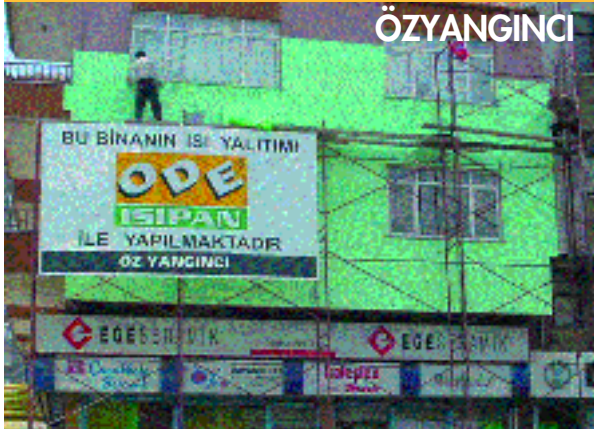
Firma Adı : Özyanginci Uygulama Yapılan Yer : Apartman Yapılan Uygulama : 300 m 2 ODE Sistem - Isı Yalıtım Uygulaması Kullanılan Malzeme : 3 cm ODE Isıpan MD
