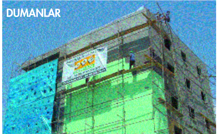
Firma Adı : Dumanlar Uygulama Yapılan Yer : Dumanlar İş Merkezi Yapılan Uygulama : 1200 m 2 ODE Sistem - Isı Yalıtımı ve Teras Yalıtımı Kullanılan Malzeme : 3 cm ODE Isıpan MD ve 5 cm ODE Isıpan DT
